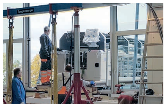
Luftige Aktion: Einbringung der neuen Reflow-Konvektionsanlage VisionXP+ Vac bei Asetronics im Oktober 2016
