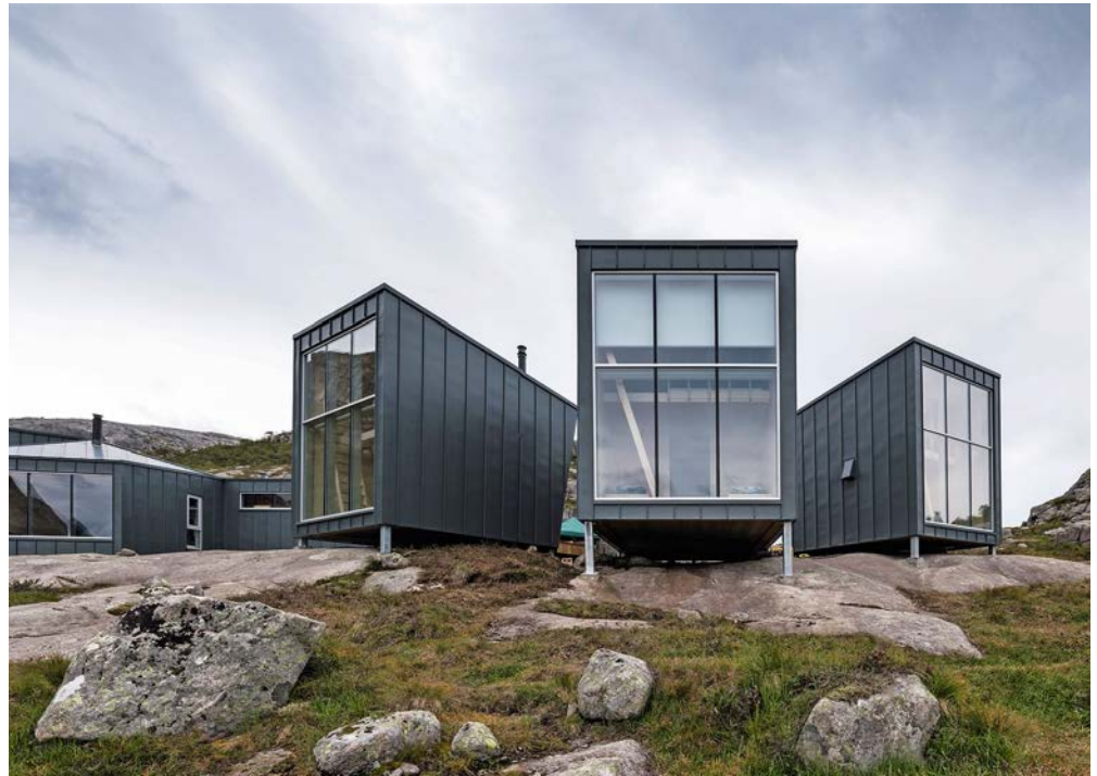
Die weitgehend vormontierten Gebäudemodule bestehen aus Holz, Dach- und Fassadenbekleidung sind aus Titanzink.
