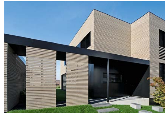
Die geplante Geometrie wurde exakt umgesetzt mit planebenen Aluminium-Verbundelementen, die sich ohne Verwerfungen kanten lassen.
