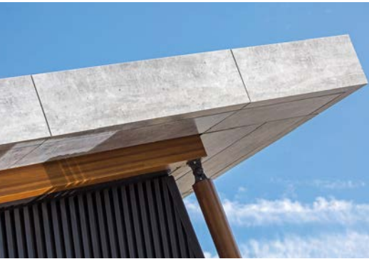
Kühn konstruiert: Das Materialkomposit lässt sich exakt kanten und biegen – dank seiner Dreischichtigkeit und seines geringen Flächengewichts.
