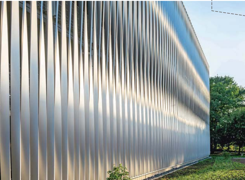
Die Lisenenfassade mit gedrehten Elementen sorgt für besondere visuelle Effekte.
