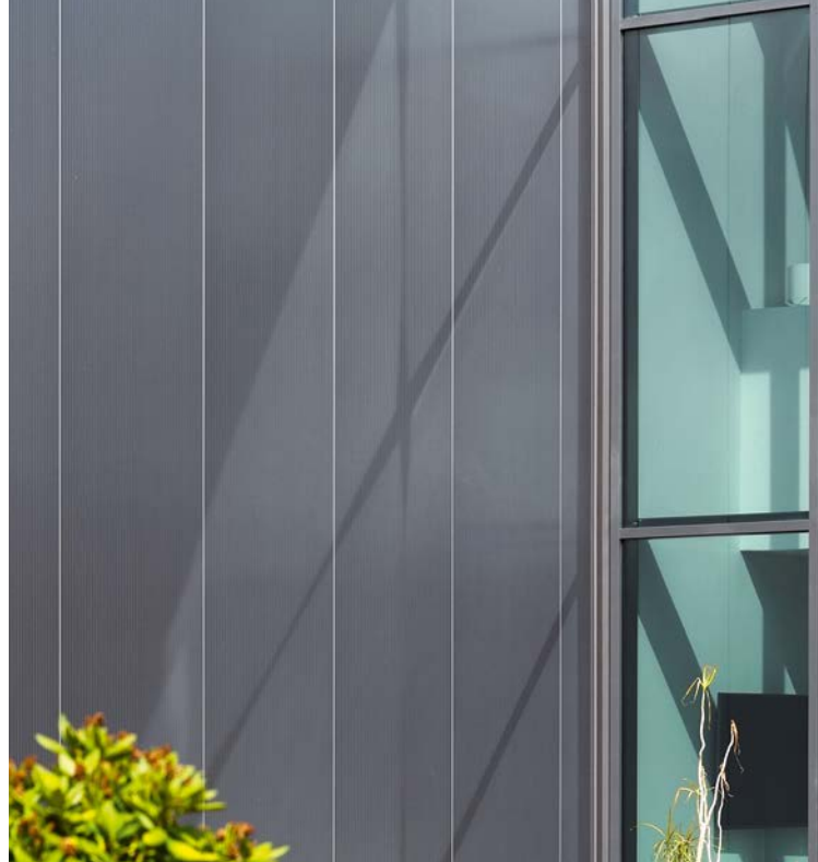
Die opaken Flächen wurden mit Sandwichpaneelen gestaltet. Ihre metallische Oberfläche zeichnet sich durch leichte Mattheit und edlen Schimmer aus.
