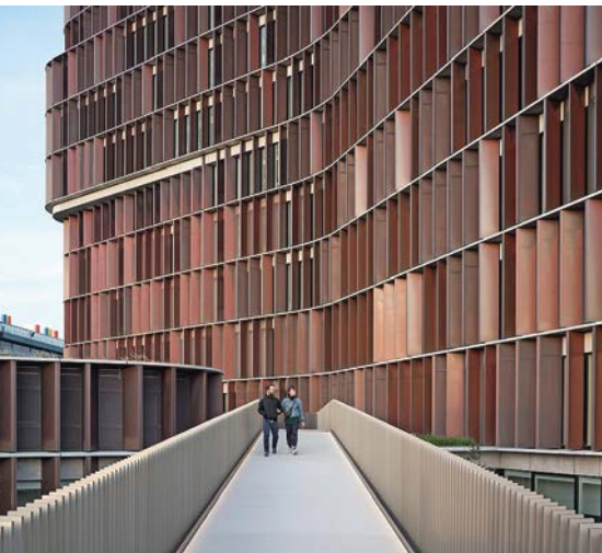
Bei einem Drittel der 3300 Lamellen lassen sich integrierte Paneele aus Kupfer-Streckmetall je nach Sonnenstand vor die Glasfassade verschieben.
