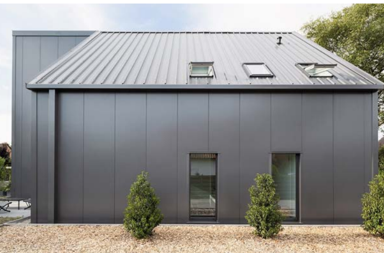
Die Dachelemente sind mit werkseitig integrierten Velux-Fenstern erhältlich und ermöglichen so eine schnelle und unkomplizierte Montage.
