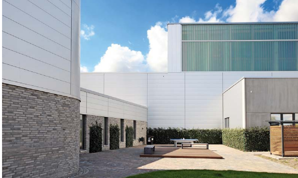
Der Sockel des Verwaltungsgebäudes hebt sich mit grauem Verblendstein von der aufgehenden Aluminiumfassade ab. Bei der Lagerhalle sorgt Profilbauglas für Lichteinfall.
