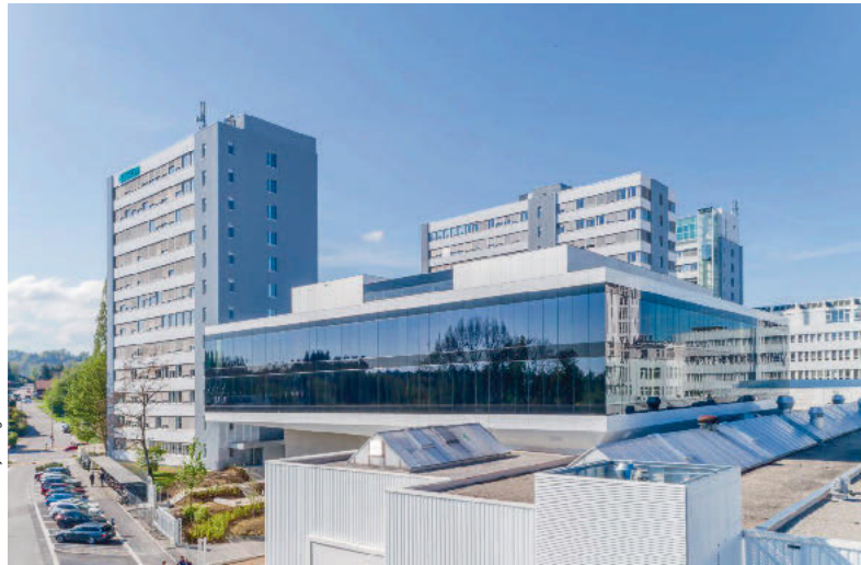
Die elektronisch schaltbare Ganzglasfassade verdunkelt sich bei Sonneneinstrahlung. Es entstehen unterschiedliche Farbeindrücke und Spiegelbilder.
