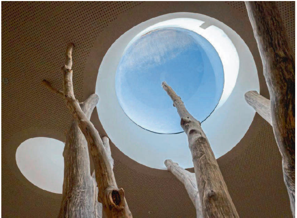
Insgesamt acht runde Flachdachfenster wurden integriert.
