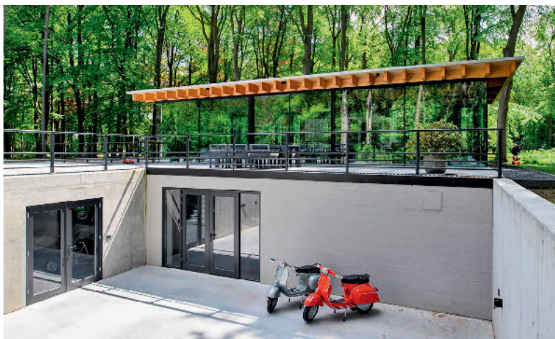
Der alte Betontrog des Trinkwasserkellers wurde mit Glasschiebetüren zum Tageslicht hin geöffnet.
