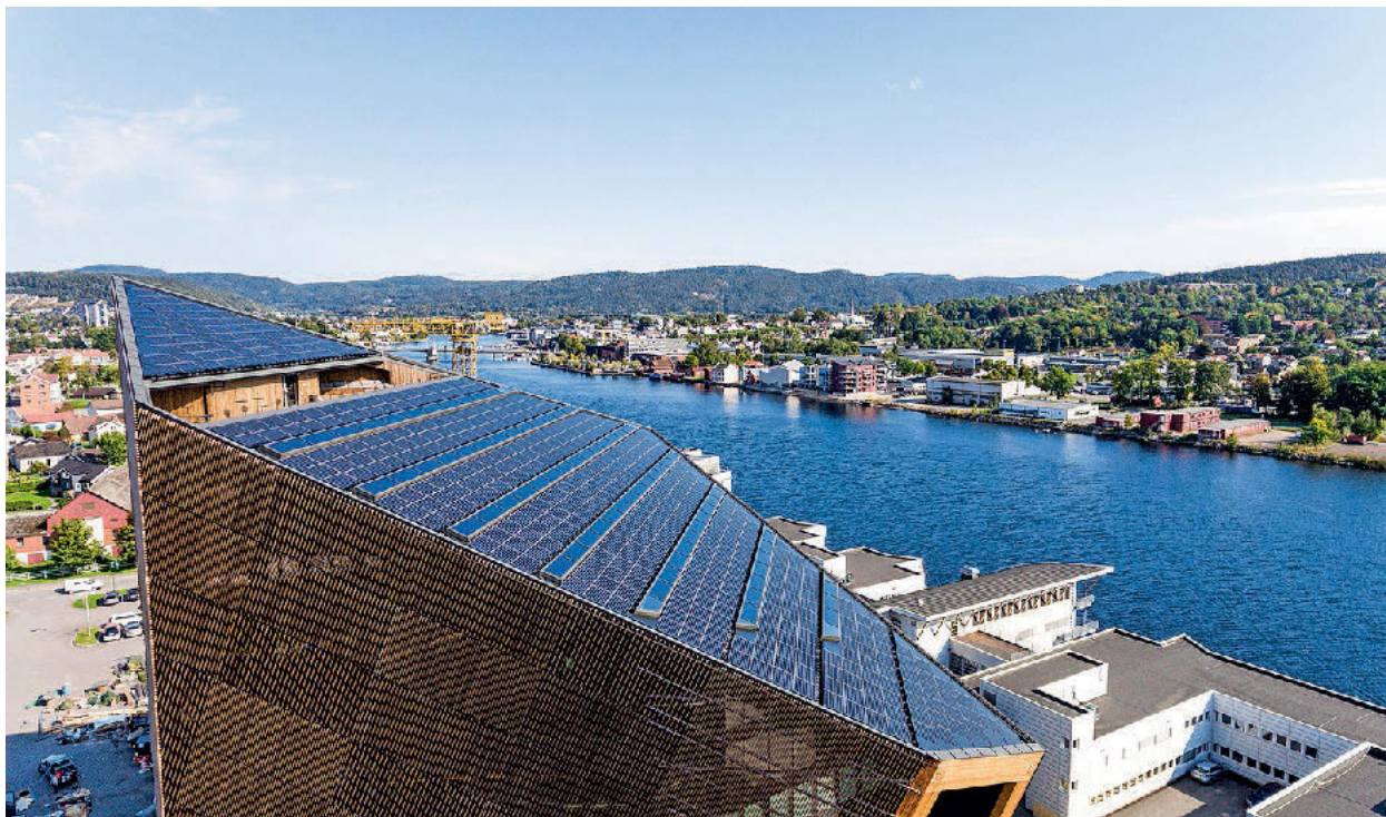
Das stark geneigte Dach ist fast vollständig mit Photovoltaik-Panels belegt. Lichtbänder mit Oberlichtern dienen der Belichtung der Tagungsräume darunter.
