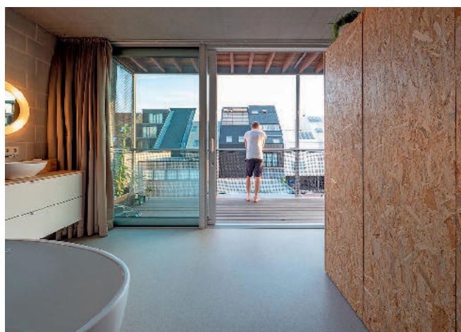
Die Südfassade in Richtung Garten wurde als luftige Rahmenkonstruktion mit raumhohen Fenster- bzw. Schiebetürelementen ausgeführt.
