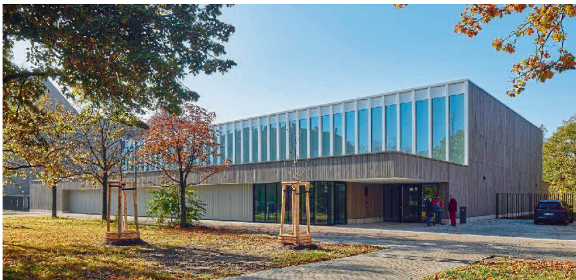
Kapillarplatten im Isolierglasaufbau sorgen im Innern der Turnhalle für eine gleichmäßige und blendfreie Ausleuchtung. Einblicke gibt es nicht — die Spiegelbilder der Umgebung bleiben erhalten.
