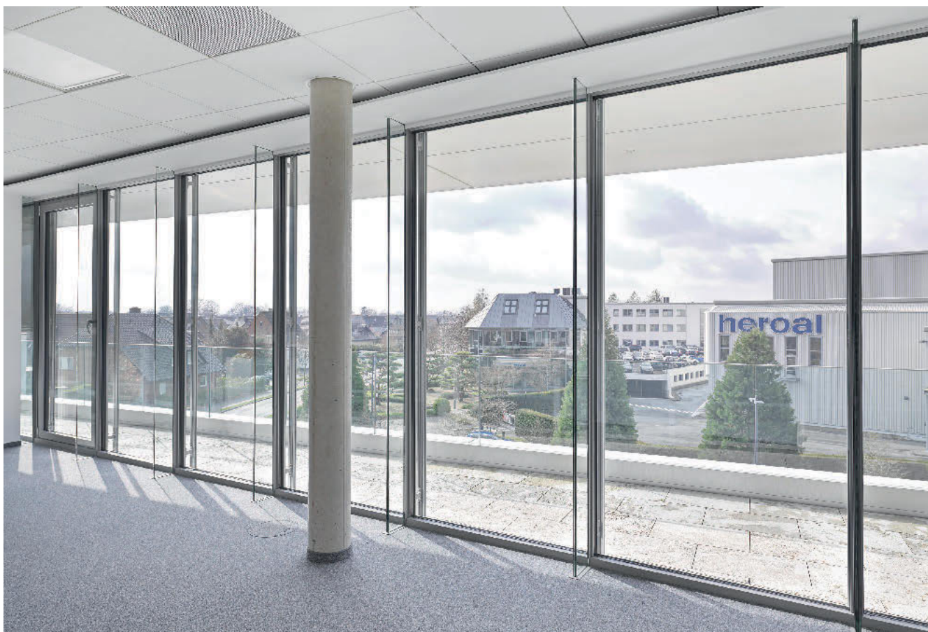
Viel Tageslicht beim Arbeiten: Glaspfostenfassade mit Glasschwert statt klassischer Aluminium-Pfosten.
