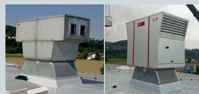
Problemlose Modernisierung: Die neue Gerätegeneration passt genau auf die vorhandenen Dachöffnungen.
