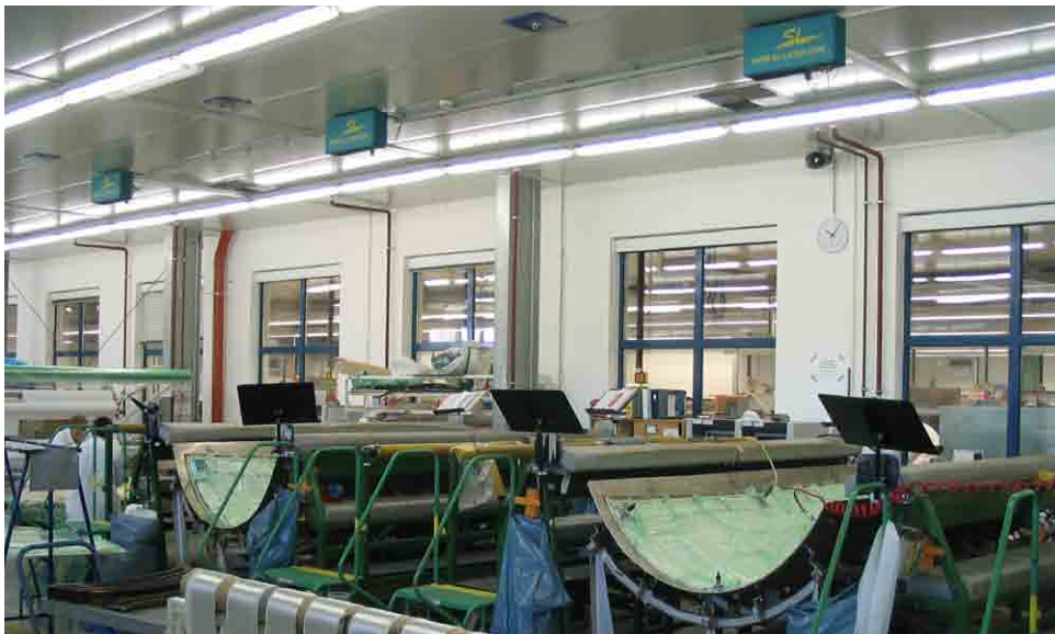
Installation des Lasers über einem Tool / Form
