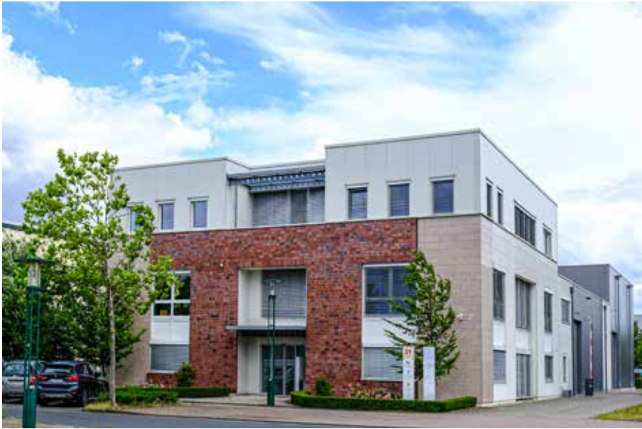
Firmensitz im Stahlwerk Becker in Willich
