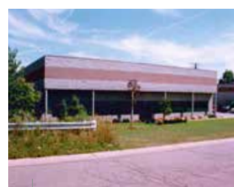
1999 Offizieller Produktionsbeginn im Werk USA
